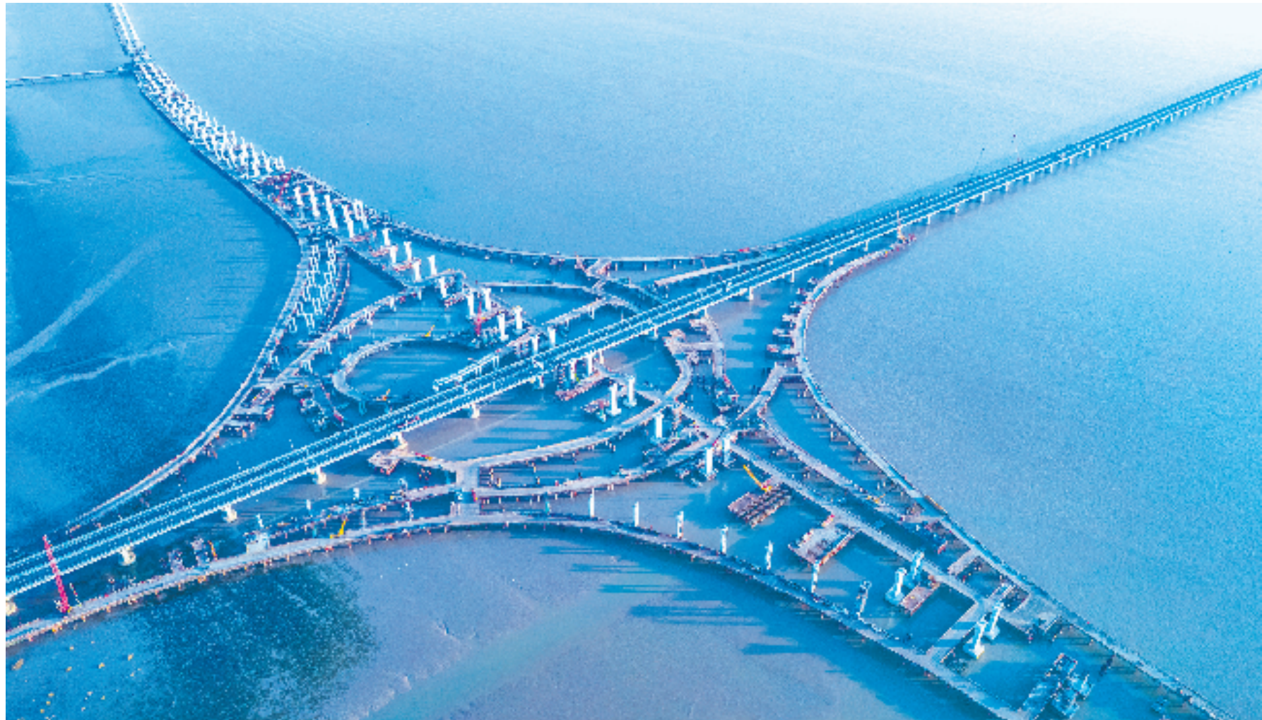
杭甬复线宁波一期项目滨海互通正加快建设
