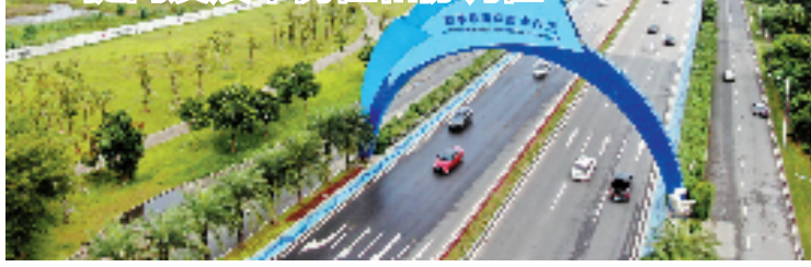
这是日前拍摄的横琴大桥。
