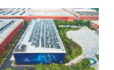
国网浙江综合能源公司申洲国际分布式光伏项目
