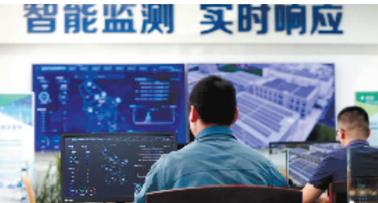
国网浙江综合能源公司智慧光伏(浙东)分中心,是浙江省首个分布式光伏电站区域监测运维中心。
