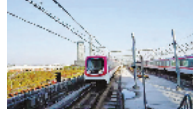
图为绍兴地铁1号线。绍兴市轨道交通集团供图
