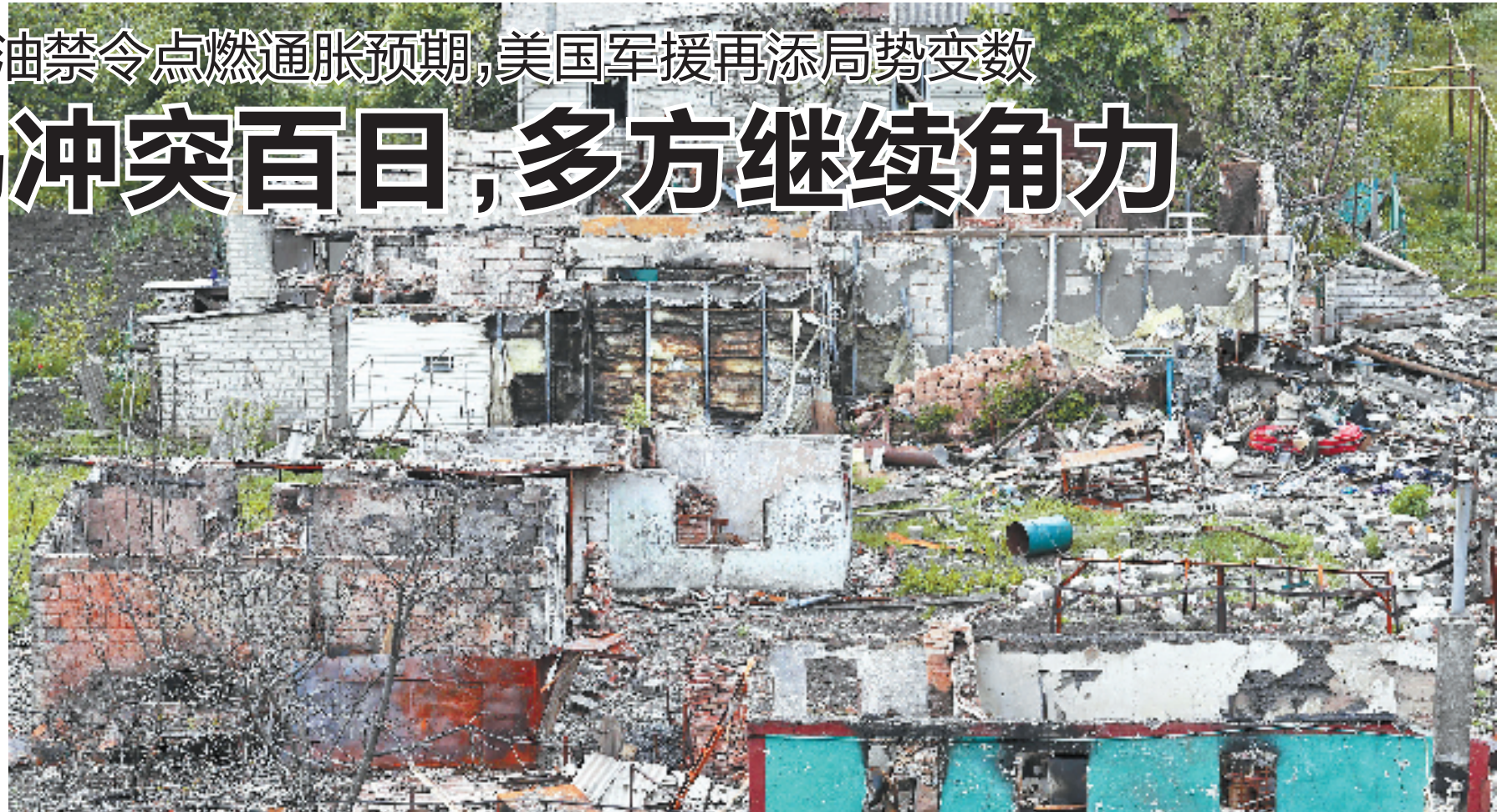
这是5月26日在卢甘斯克波帕斯纳亚拍摄的被损坏的建筑。本版图片均新华社发
