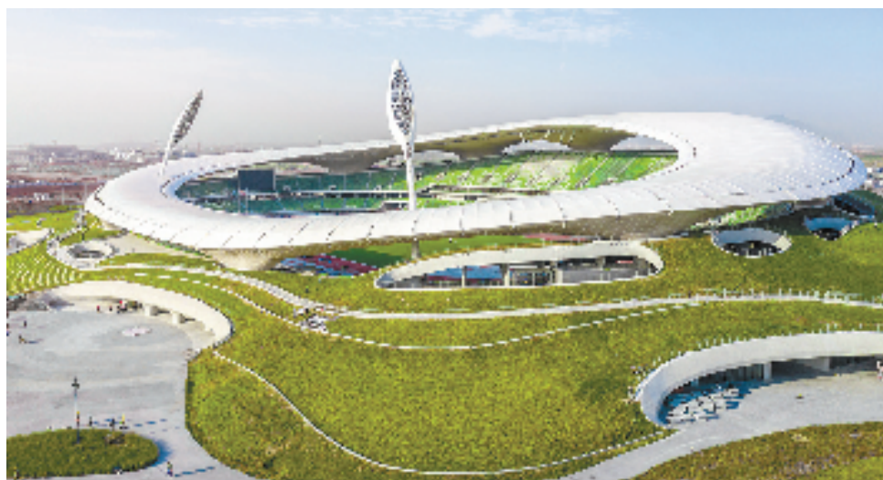
衢州体育中心已成为衢州地标建筑 许军 摄
