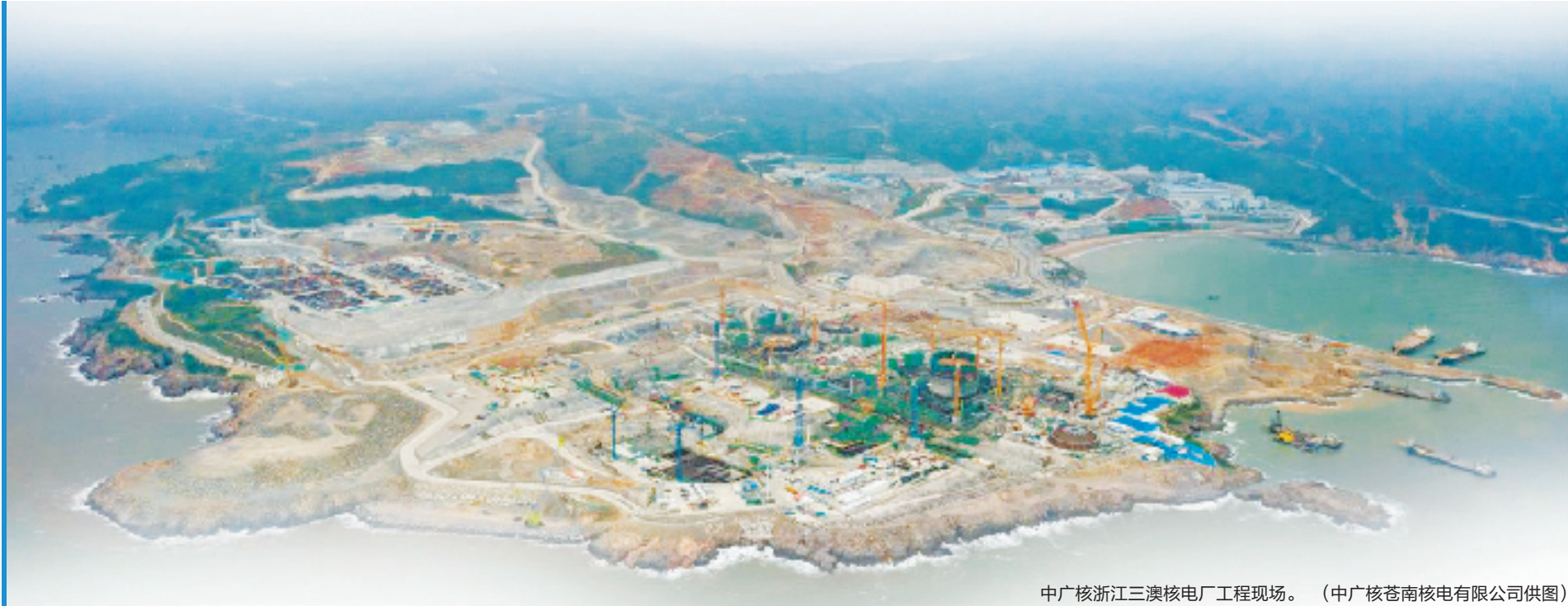
中广核浙江三澳核电厂工程现场。(中广核苍南核电有限公司供图)
