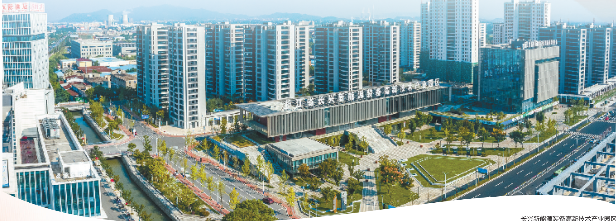
长兴新能源装备高新技术产业园区
