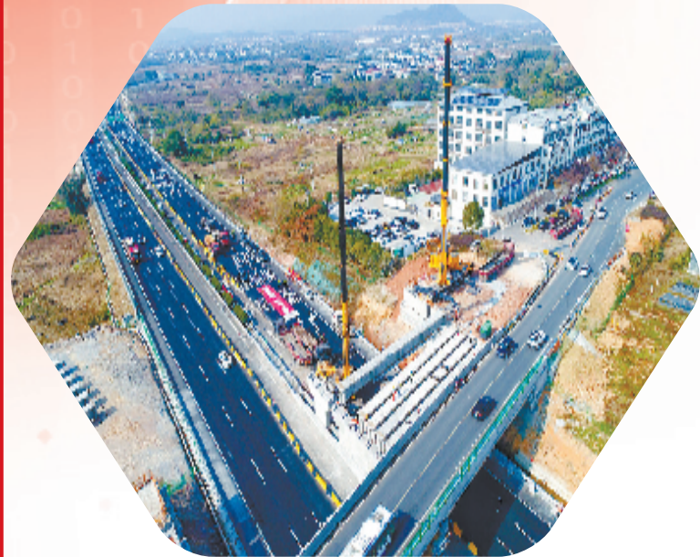
杭金衢改扩建二期项目开展天桥梁板架设、防护装置拆除、中分带整治等集约化施工。
