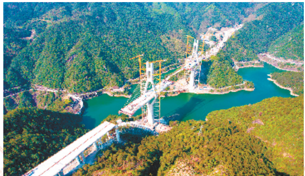
景文高速施工现场
