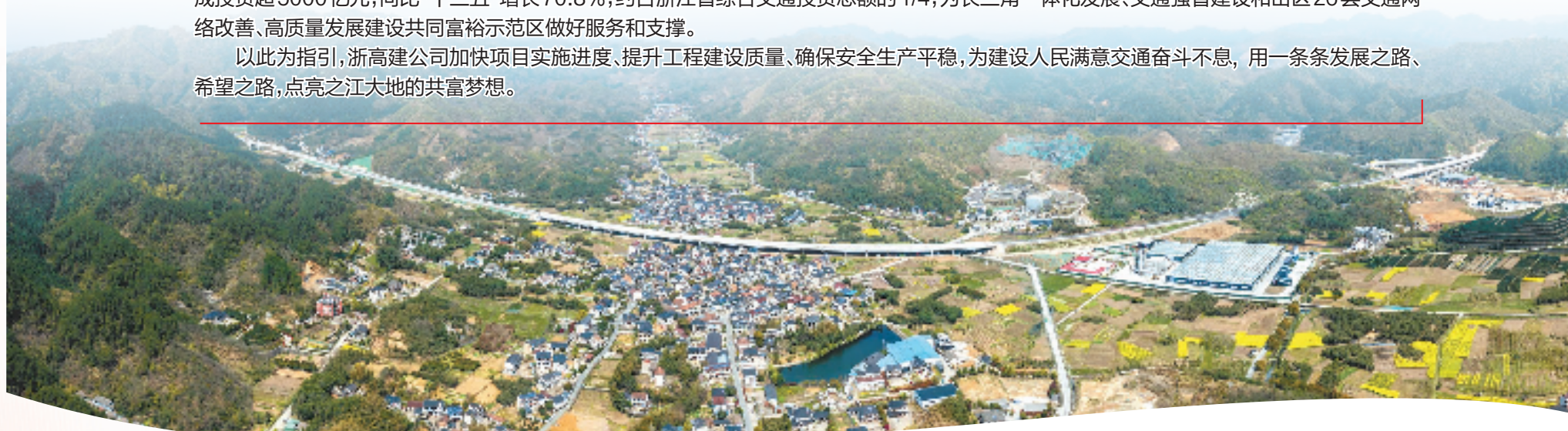
临建高速智慧路面站及路基段
