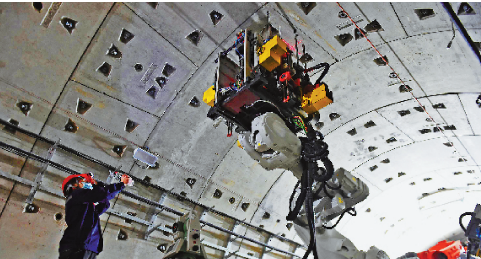
5月28日，一套智能植栓设备在杭州地铁3号线仓前停车场的隧道内调试。这套由中铁建电气化局与浙江大学联合研发的铁路施工智能装备，可自动实现在隧道壁上打孔、注入胶水、植入螺栓等操作，大大提高地铁接触网的铺设效率。图为智能植栓设备在隧道顶部打孔植栓。
