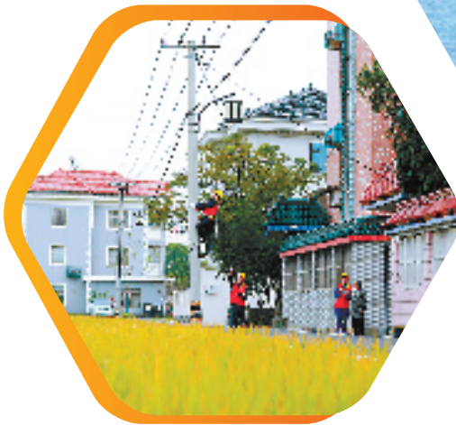
国网杭州市萧山区供电公司员工到梅林村开展电力线路巡视检查和安全生产知识宣传
