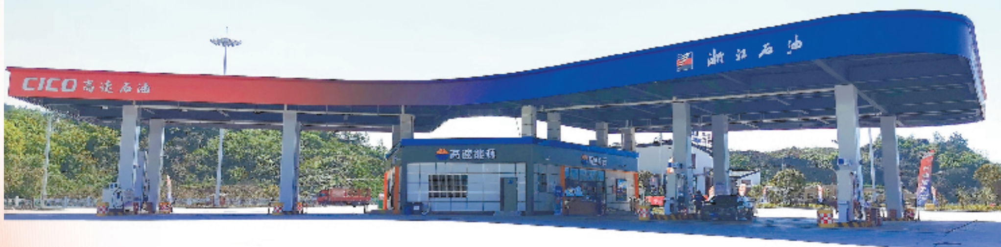
浙江高速能源加油站
