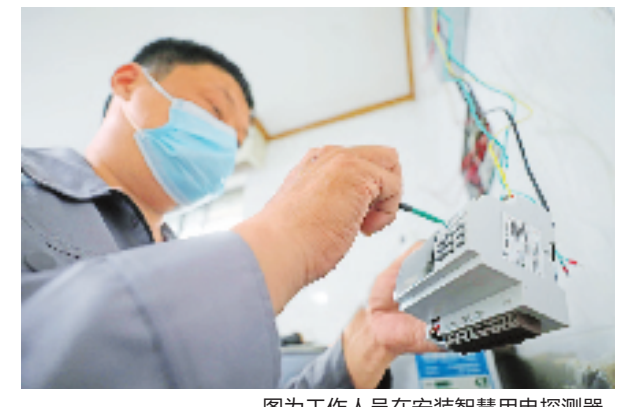
图为工作人员在安装智慧用电探测器。
