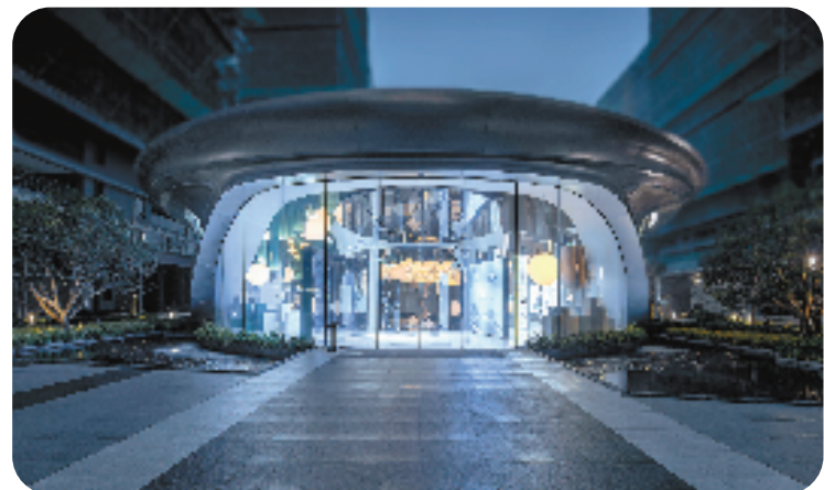
未来云帆城示范区外立面实景图
