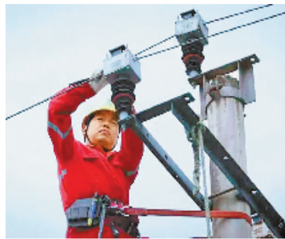
国网诸暨市供电公司员工正在安装一体式防雷神器 周金那 杨琪凯 摄
