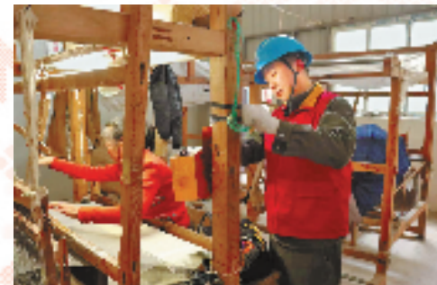
电力工作人员为泰顺包垵乡织麻来料加工厂检查用电设备 包舒静 摄
