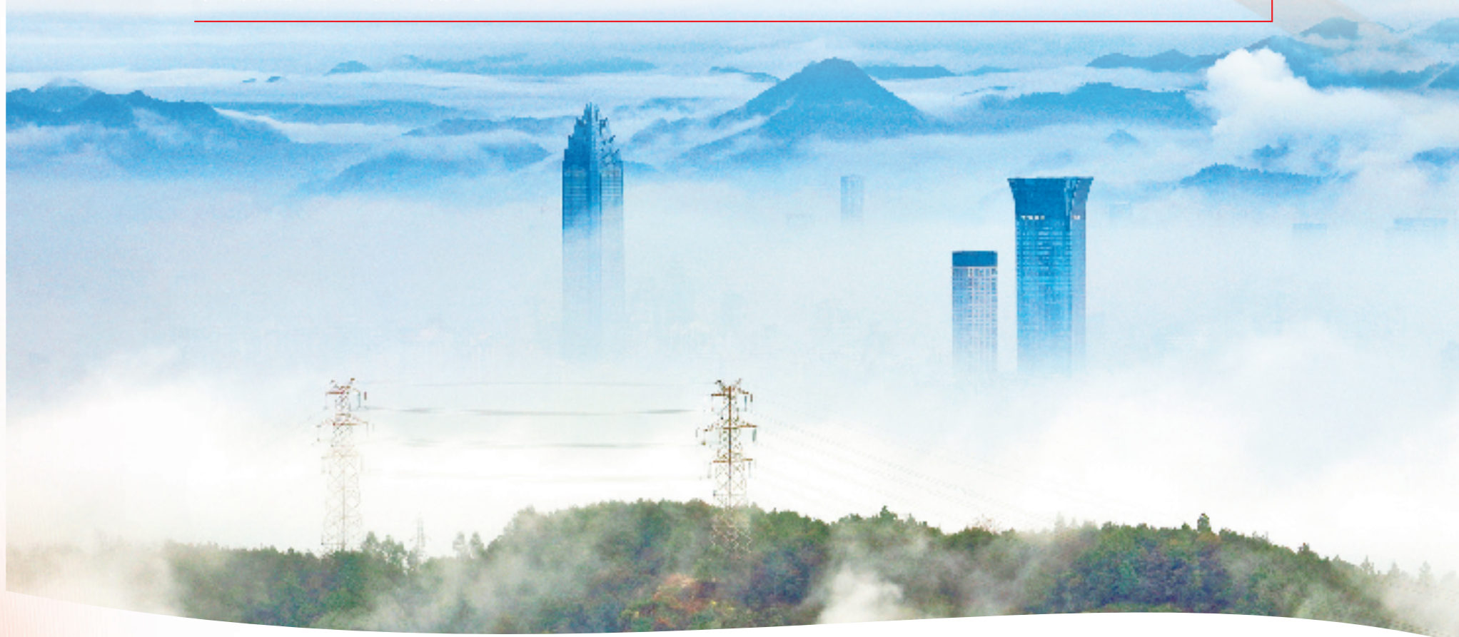
致力打造“千万千瓦”级自适应新型电力系统的温州电网 黄周虎 摄
