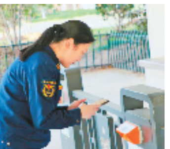
衢州市消防救援支队监督员在电动自行车数字智能安全充电桩前,尝试用手机扫码充电。 饶小飞 摄
