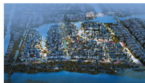
北海街道快阁苑小区改造项目效果图 (图片由越城区北海街道办事处提供)
