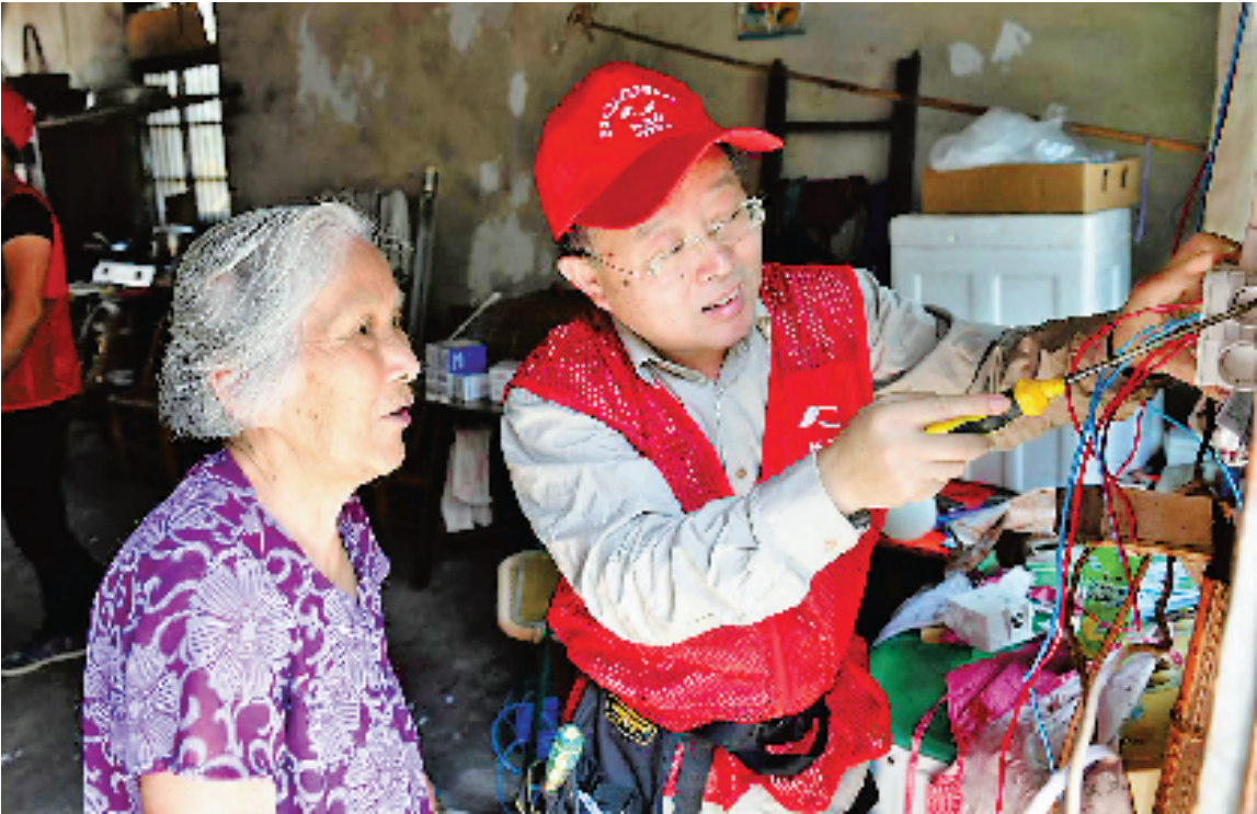
钱海军为群众免费改造室内照明线路。
