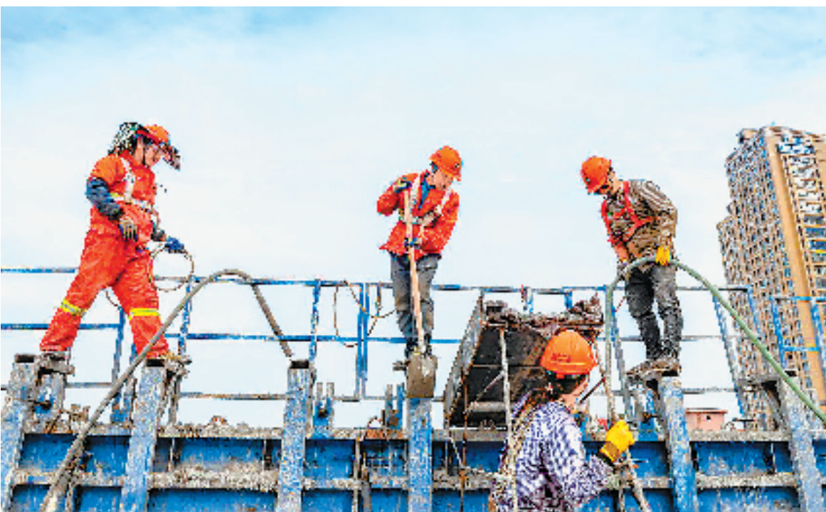
义东高速湖田枢纽跨甬金高速施工现场,工人们抓紧施工。
