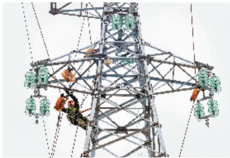
4月30日,“五一”假期首日,在台州市路桥区金清镇海峰村,电力工人假期不停工,爬上铁塔架设导线。 孙金标 摄
