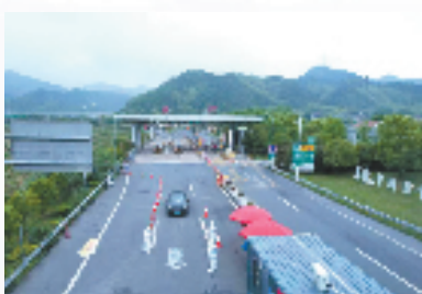
建德乾潭高速口
