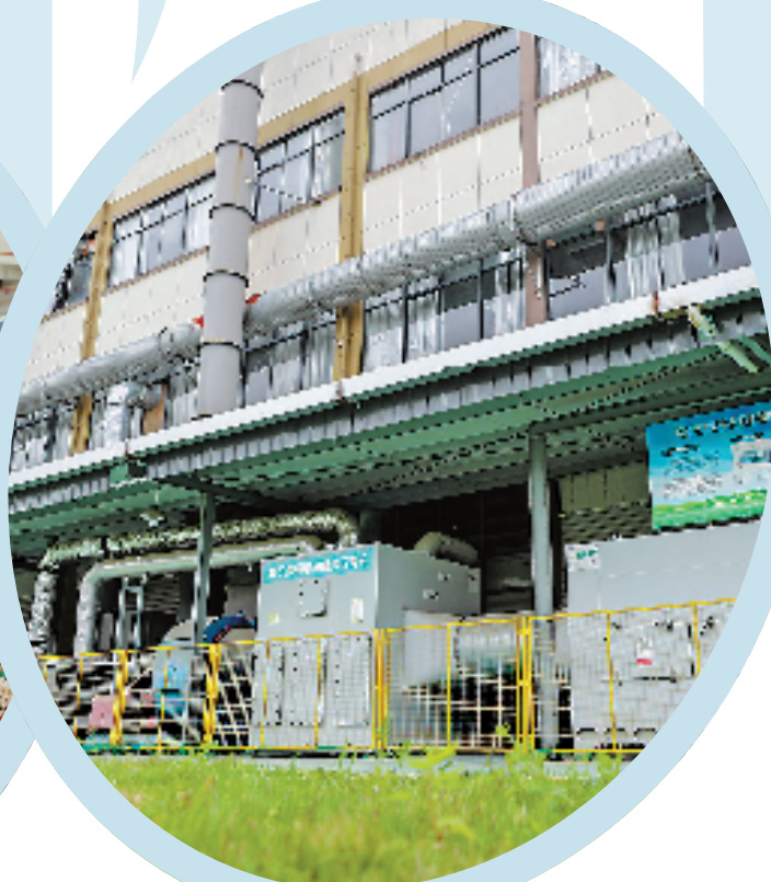
钢琴油漆共享中心的废气处理设备。
