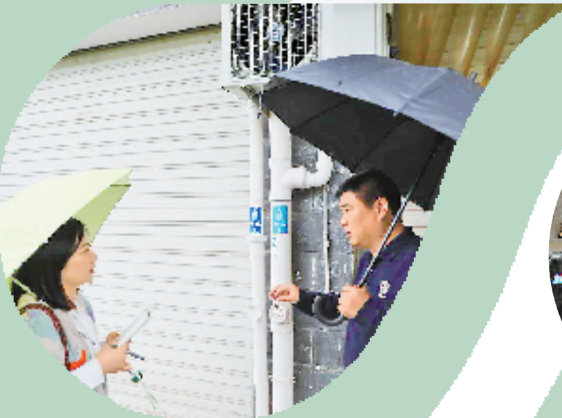
姜家镇党委书记陈君(右)带记者查看居民楼雨污分流管道
