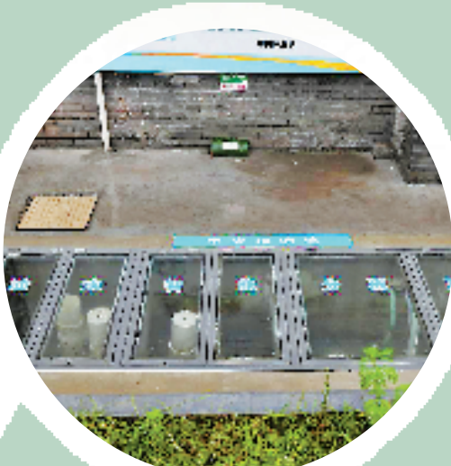
去油污的“中央隔油池” 共享联盟淳安站 张渊凯 摄
