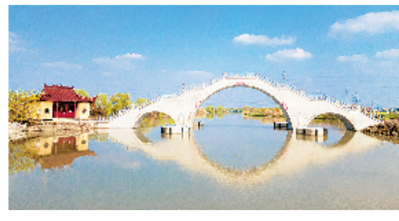
日前,在南浔区双林镇人大代表的建议下,在市、区水利部门的大力支持下,该镇向阳村与善琔镇施家桥村交界处的明初五孔石桥——练市塘“八字桥”,历经近两年时间,总投资约500万元,终于得到了修复,为老百姓出行提供了便利。 张斌 文/宋元锋 摄
