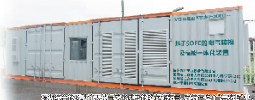
滨湖综合能源站将天然气转化成电能的存储装置,就装在这个“集装箱”中。
