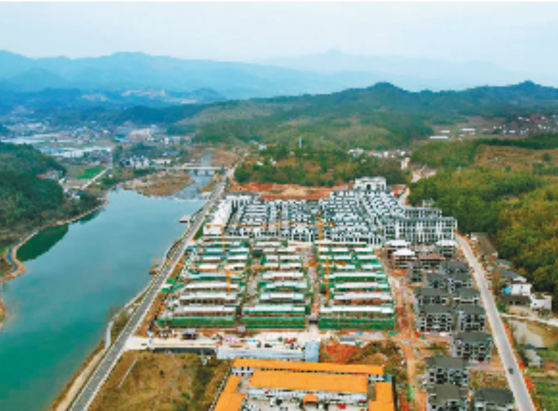
正在建设中的龙泉酒吧长寿小镇一期
