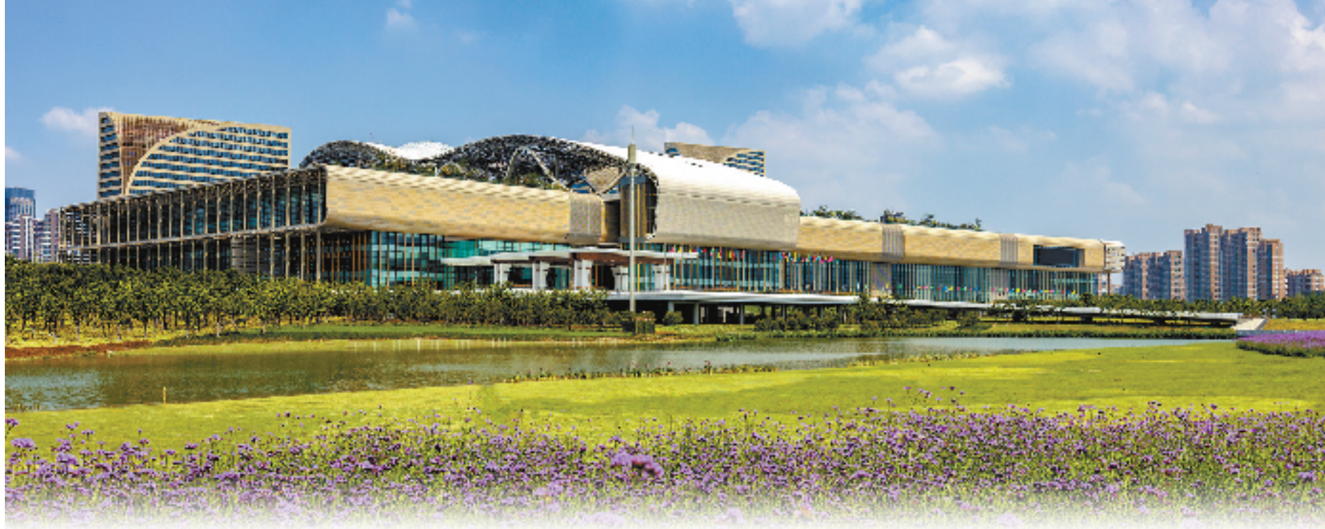
杭州国际博览中心
