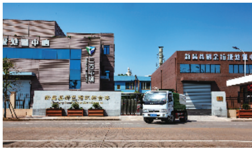
新昌县绿色循环综合体
