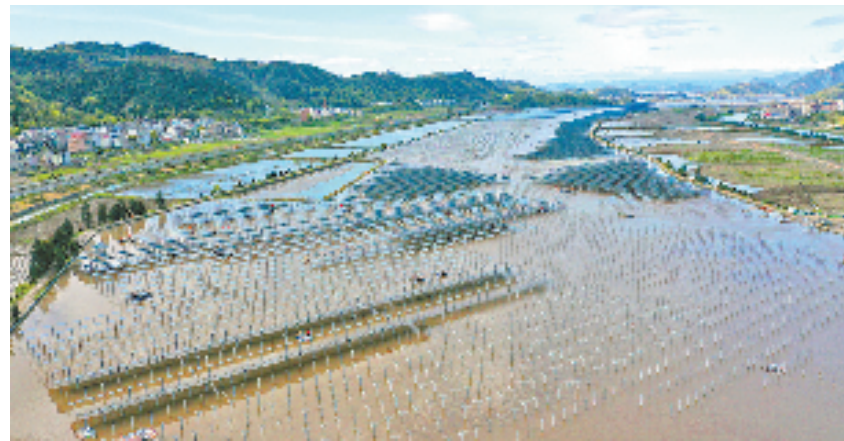
温岭江厦100MWp潮光互补光伏智能光伏发电项目正在施工中 周国军 摄
