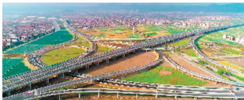
上盘镇已构建立体化交通枢纽
