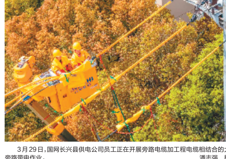
3月29日，国网长兴县供电公司员工正在开展旁路电缆加工程电缆相结合的大旁路带电作业。潘志强
