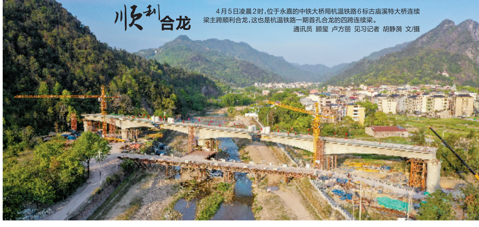
4月5日凌晨2时,位于永嘉的中铁大桥局杭温铁路6标古庙溪特大桥连续梁主跨顺利合龙,这也是杭温铁路一期首孔合龙的四跨连续梁。
