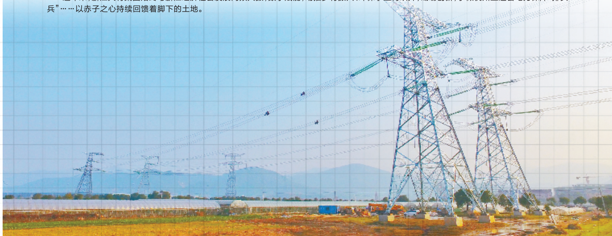
大有集团500千伏线路架设工程
