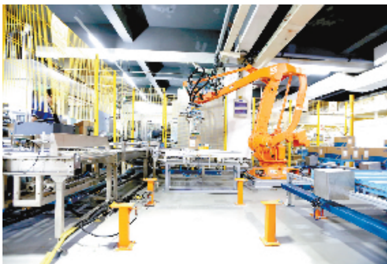
正泰数字工厂(图片由正泰集团提供) 助5.58亿元、年均增长近25%,技改覆盖了近90%的规上工业企业。其中,正泰电器打造的“正泰低压电器智能制造示范工厂”,预计在
