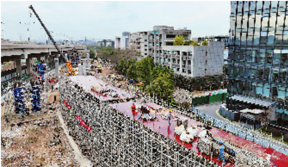
文一西路互通项目已转入上部现浇结构施工,F、G两条匝道预计今年5月底开通。
