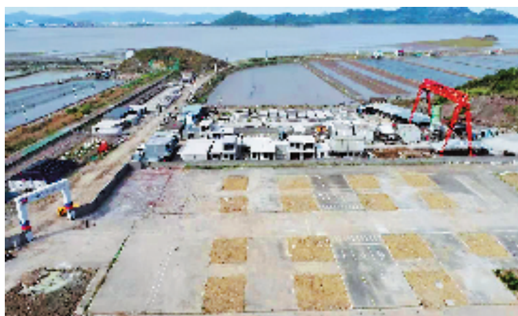
浙能台州1号海上风电场项目施工现场。 共享联盟临海站 王俊 摄
