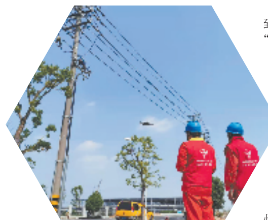
国网湖州供电公司练市供电所电力工作人员开展无人机全线巡视
