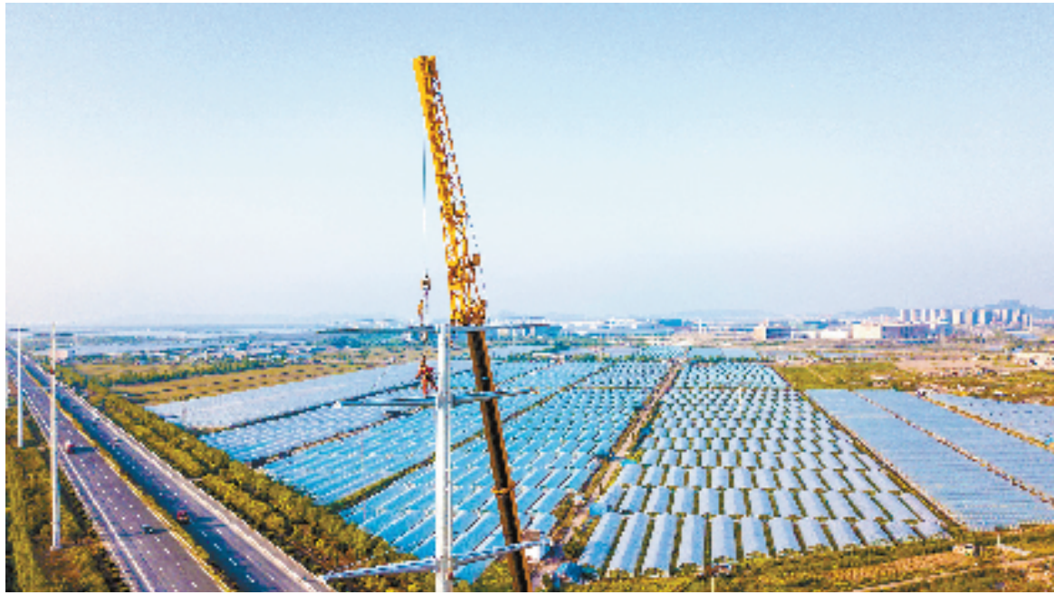
台州供电施工人员进行铁塔架设 徐伟杰 摄
