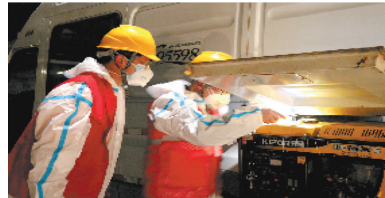
3月13日深夜,国网衢州供电公司柯城供电分公司高压配电运检二班在亚美小区应急防疫点架设照明设备,为防疫点核酸检测工作保障供电。 杨瑶佳 摄
