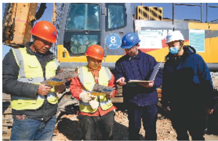
安全施工示范点 王海燕 摄
