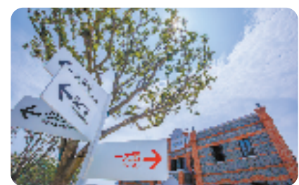
改造后的嘉兴老站房
