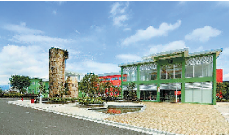
改造后的厂房。
