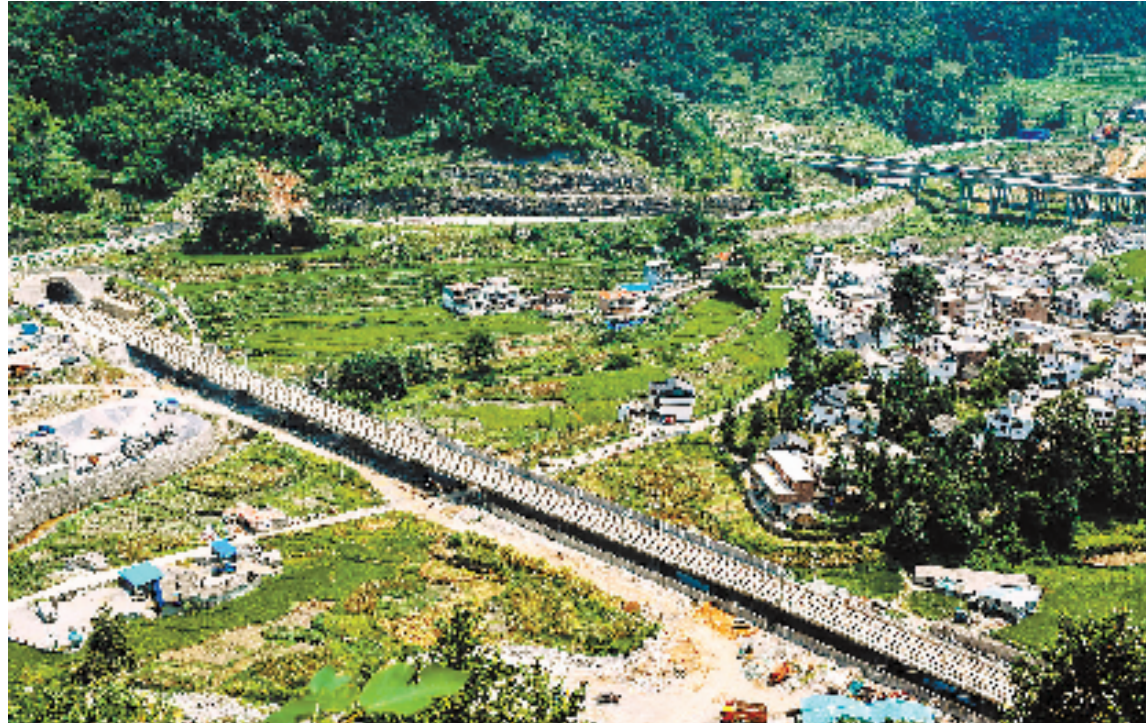
贵广高铁一座桥梁跨过贵州省黔东南州榕江县郊外的村庄。
