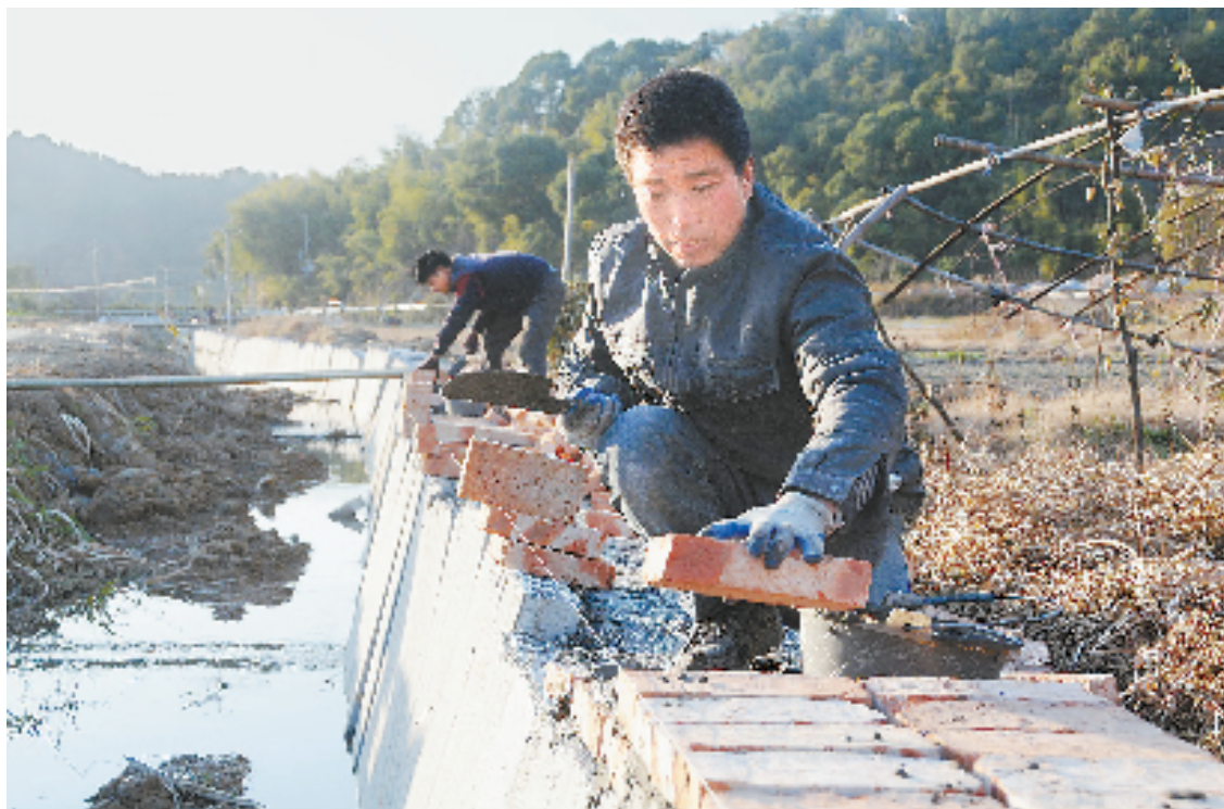
河头梁村村民梁金富在修砌河岸。最近,每天都有20多名村民自发参与工程建设。
