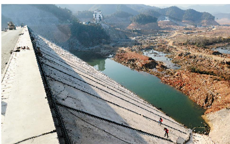
日前,杭州闲林水库大坝工程进入扫尾阶段,将于年底建成投运。建成后的闲林水库蓄水位可达70米,总库容量是西湖水容量的约1.4倍。
