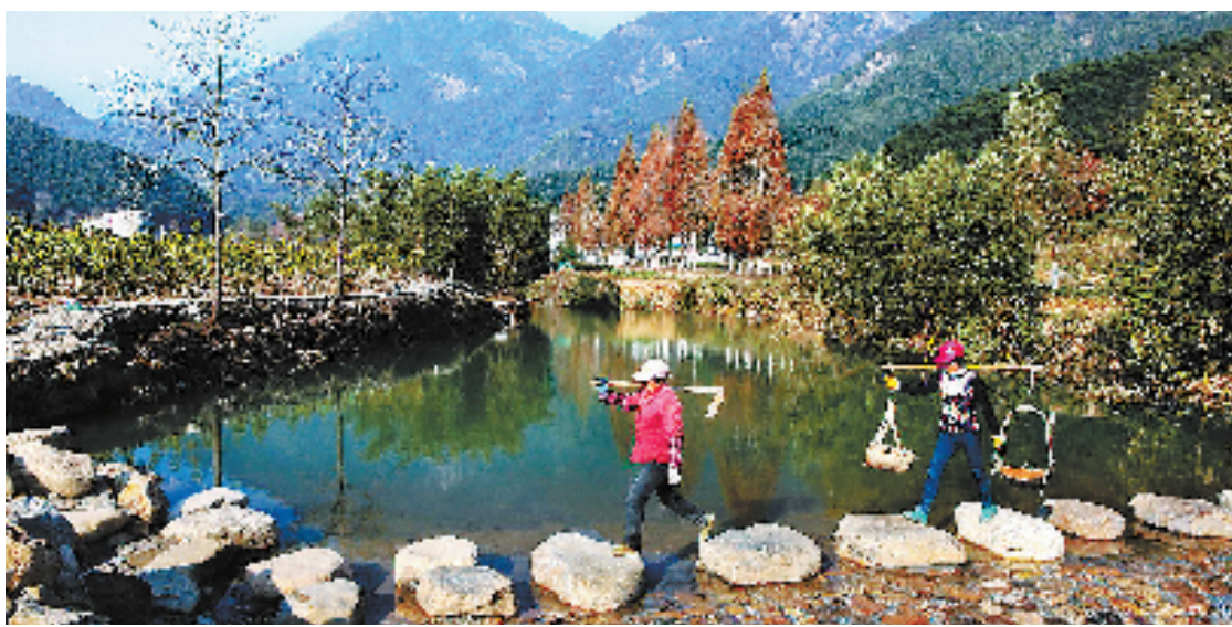
遂昌县三仁畲族乡坑口村3座生态堰坝日前建设完工。
