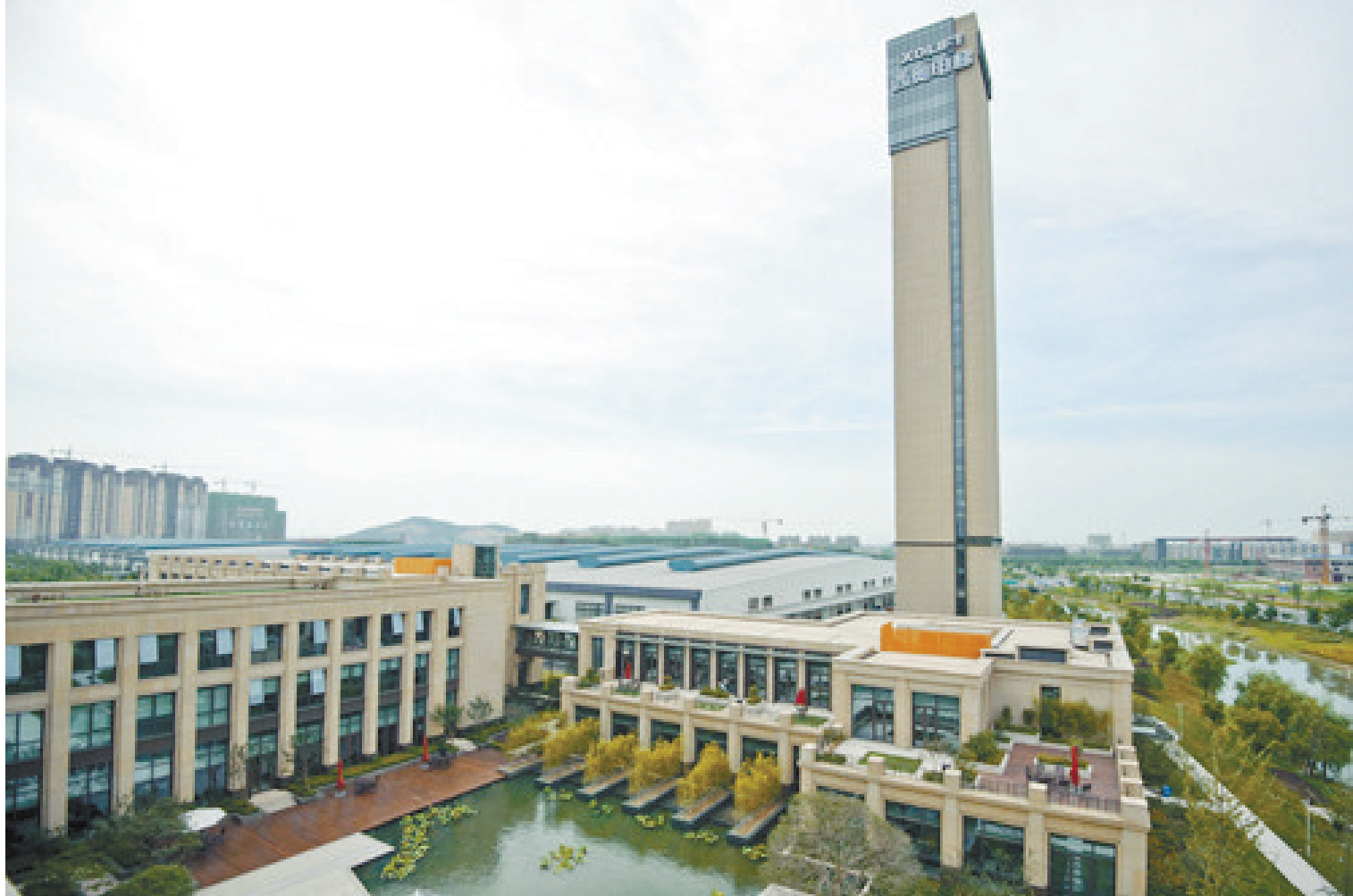
西奥电梯已拿下杭州长沙高铁线整个江西段
