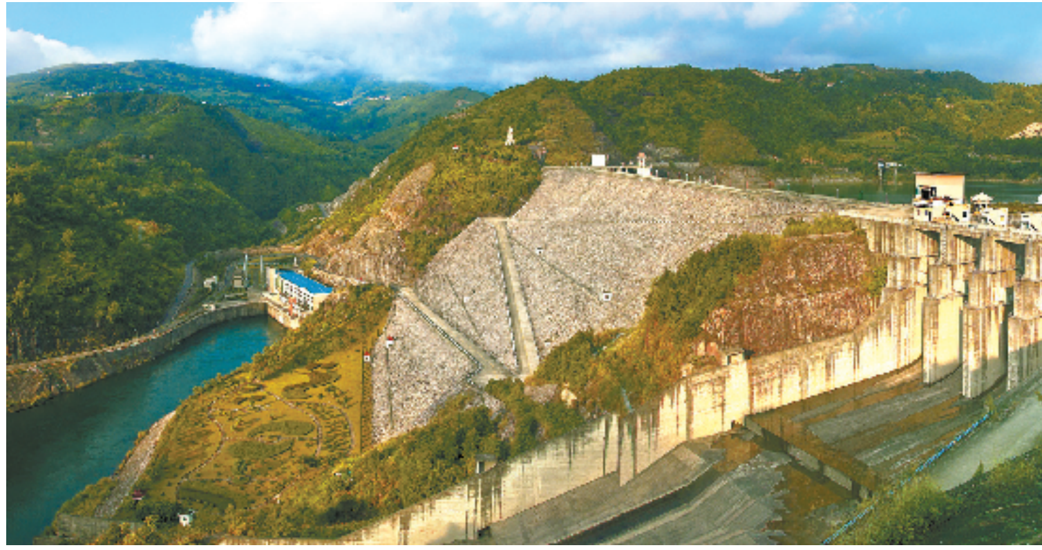
温州珊溪水库
