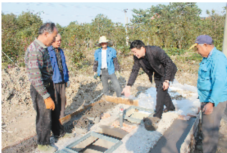
金正华(右二)在桃园村农村生活污水治理工程现场。
